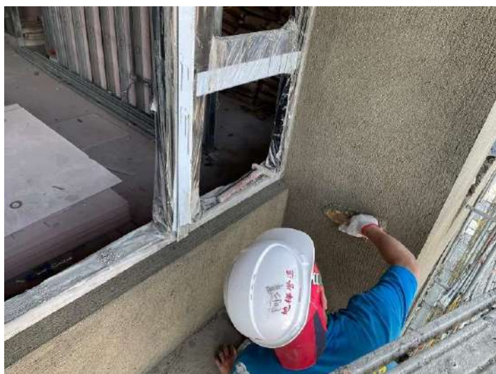
8F外牆打底施作
