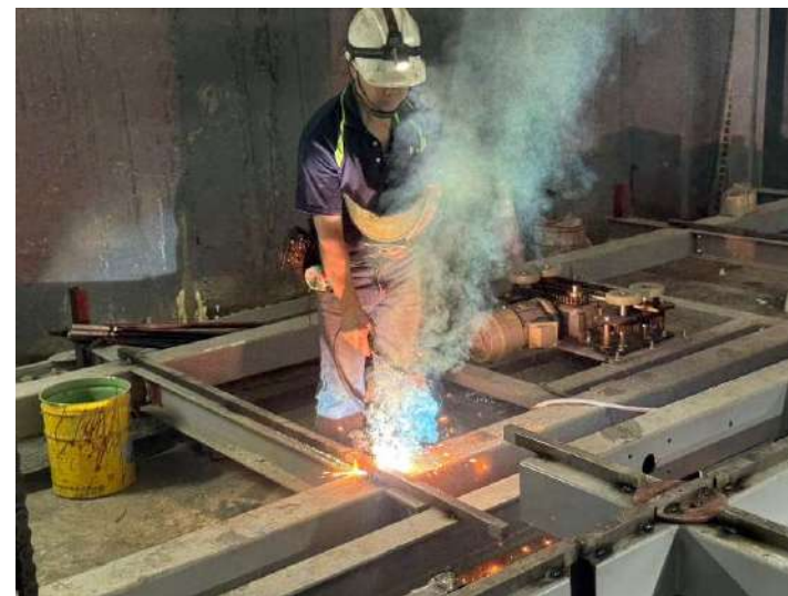
停車設備施作
