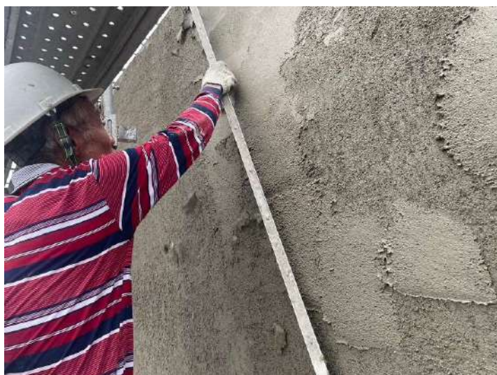
RF外牆打底施作
