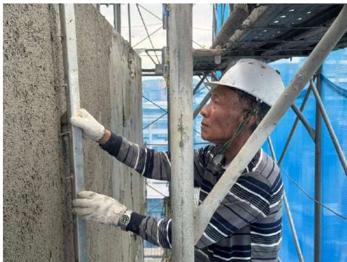
R1F外牆打底施作
