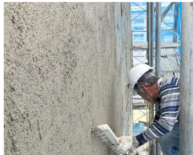
R1F牆面打底施作
