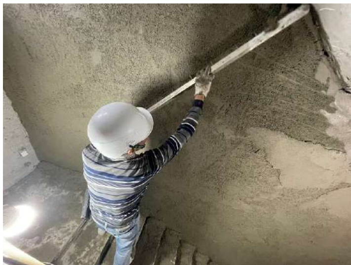
RF室內打底施作
