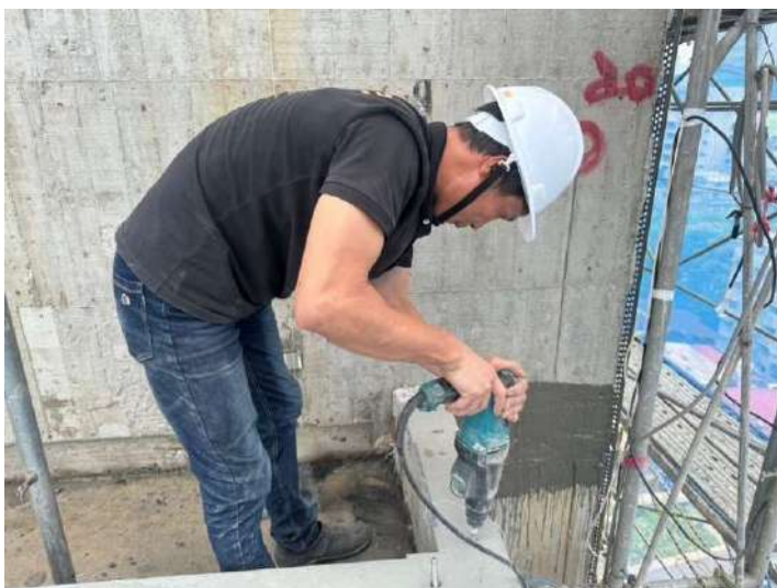
R1F欄杆基座施作
