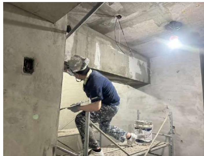
B1F-B2F油漆批土施作
