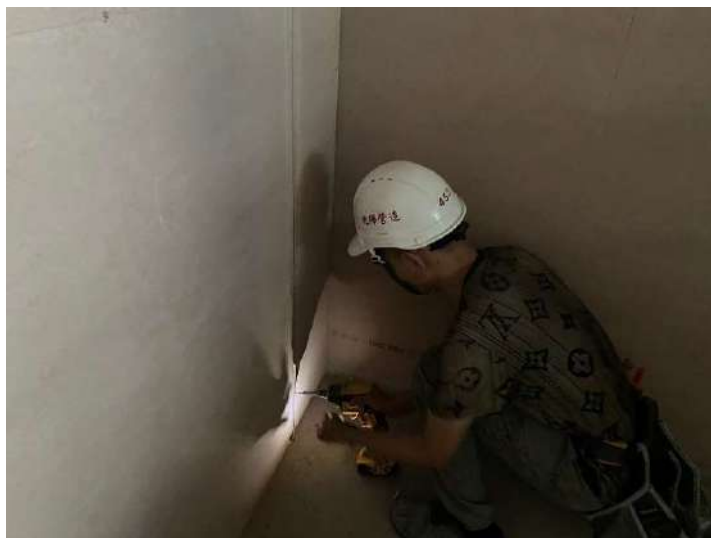
9F-12F輕隔間雙面板施作
