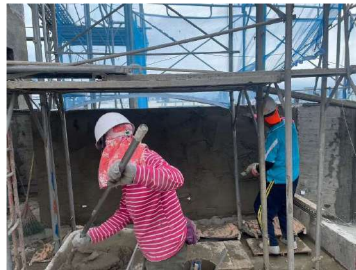
R1F外牆打底施作
