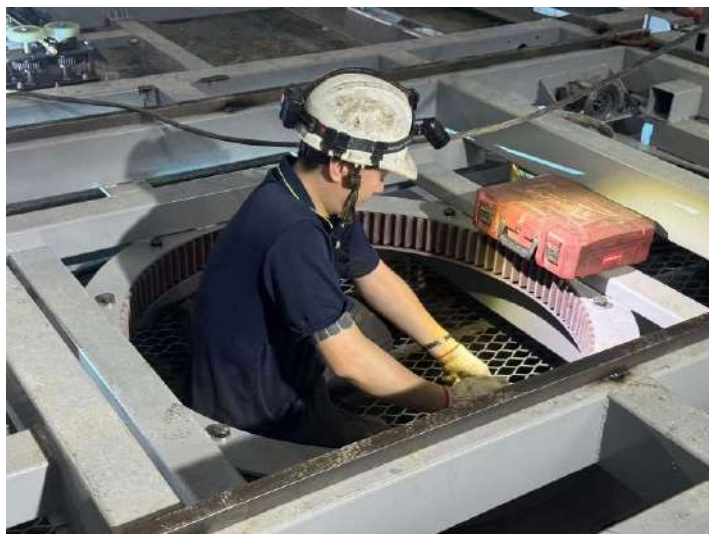
停車設備施作
