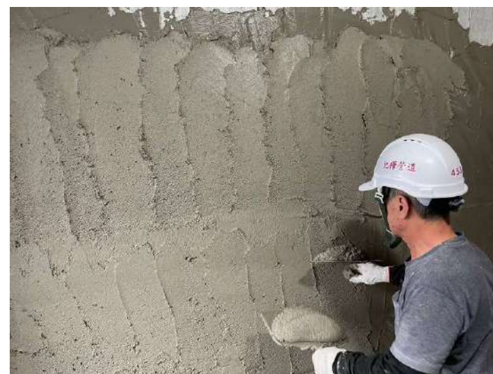
RF內牆打底施作
