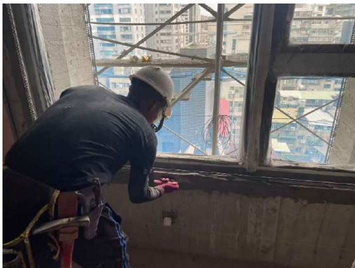
11F牆面打底灰誌、粉刷條施作
