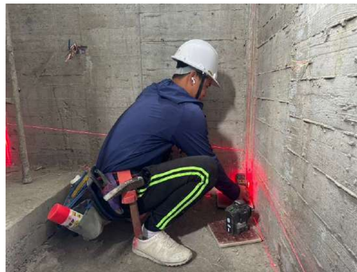
11F牆面打底灰誌、粉刷條施作
