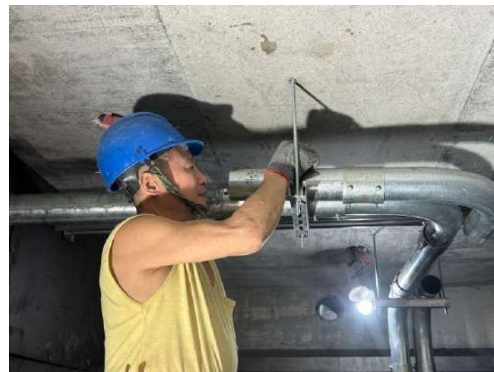
B2F電箱配管拉線
