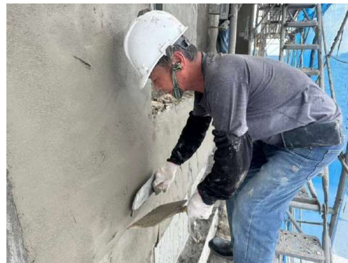
R1F外牆打底施作
