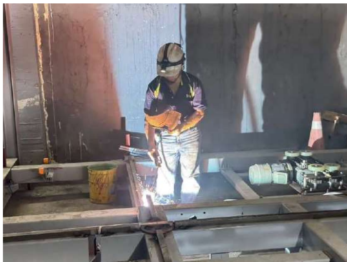
停車設備施作
