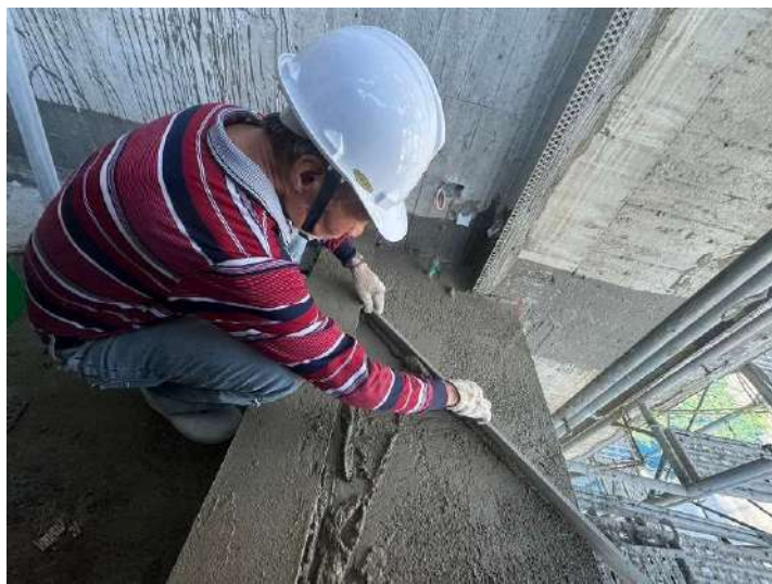
RF外牆打底施作
