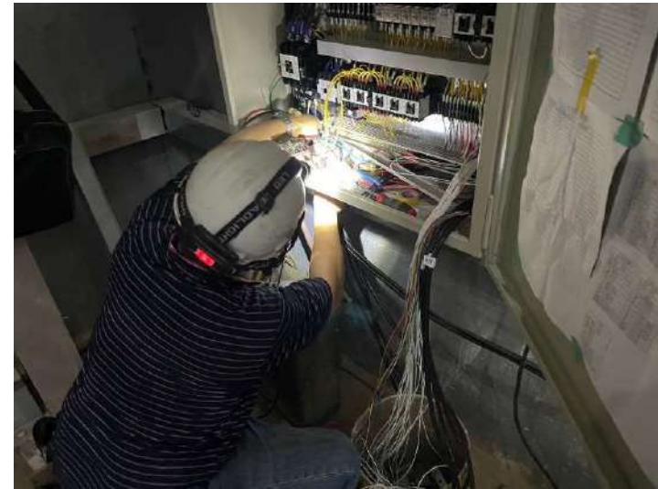
停車設備電路結線
