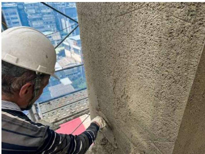
R1F牆面打底施作
