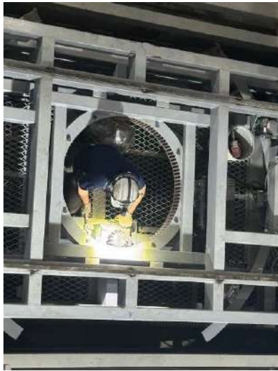
停車設備施作
