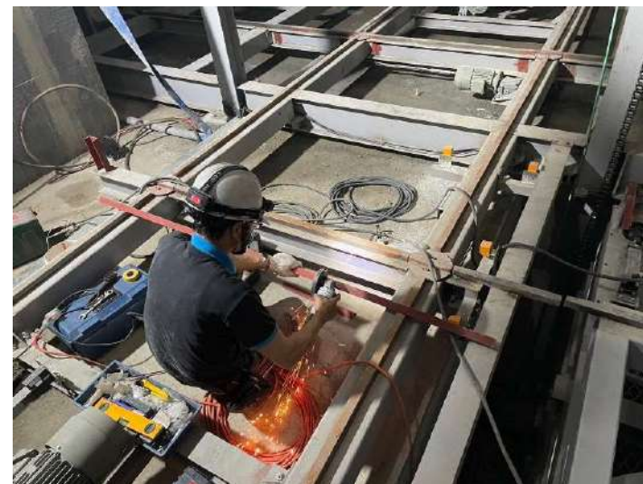
停車設備施作
