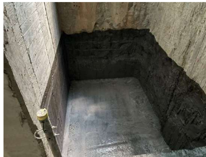
B1F機坑防水施作
