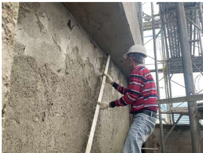
R1F外牆打底施作
