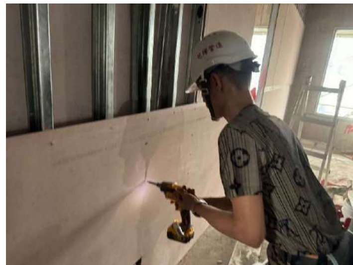
9F-12F輕隔間雙面板施作
