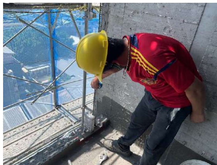
9F-12F欄杆基座施作
