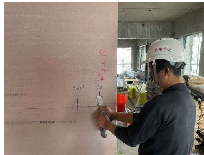
9F-12F室內輕隔間電源拉線
