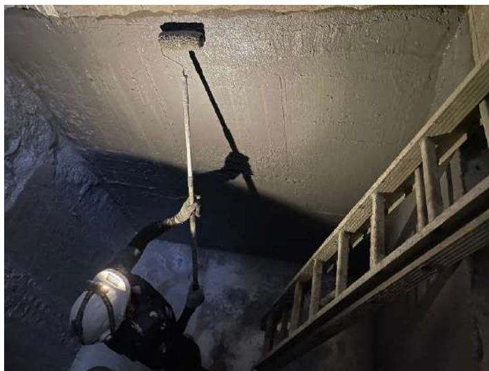
B1F機坑防水施作
