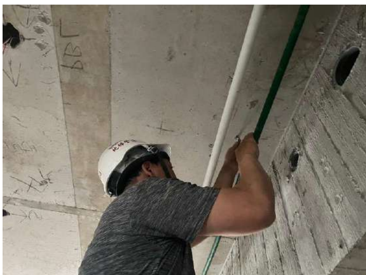
10F給水管安裝
