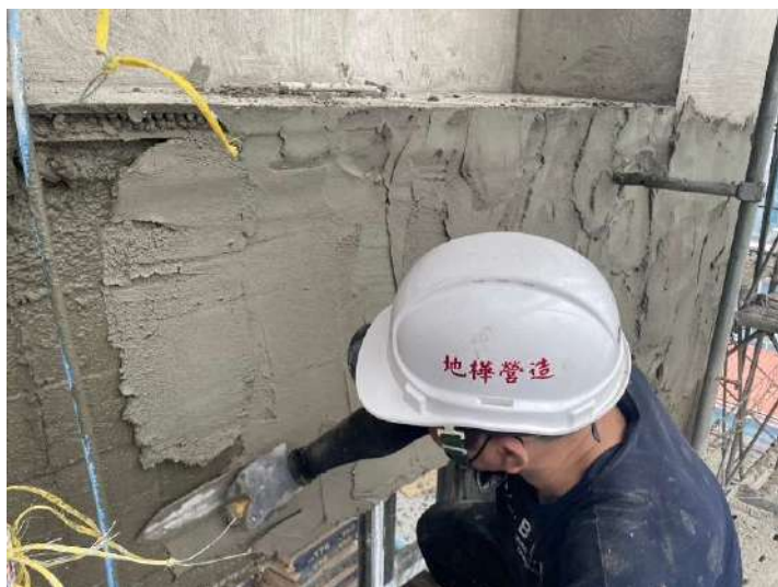
8F外牆打底施作
