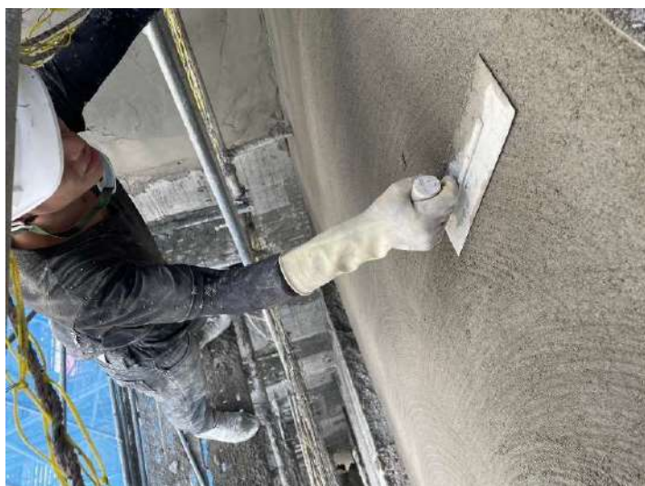
8F外牆打底施作
