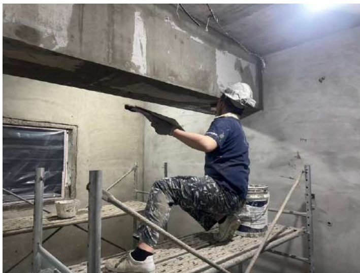
B1F-B2F油漆批土施作
