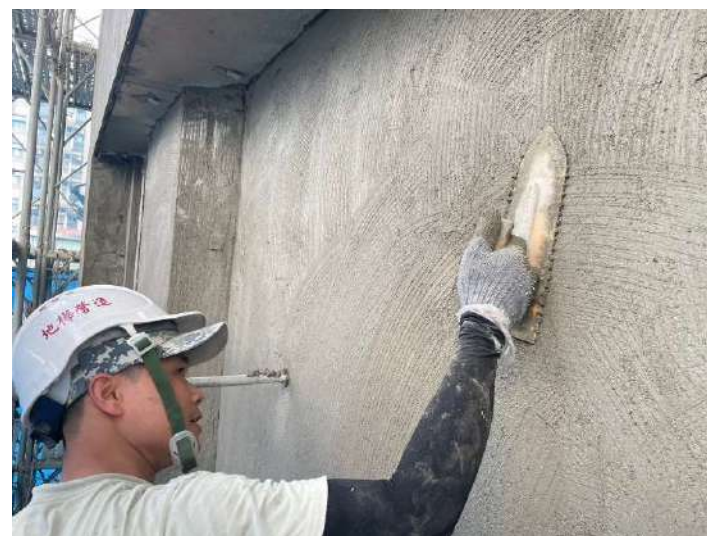
8F外牆打底施作
