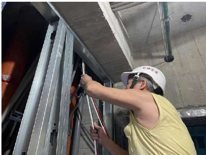
6F消防電配設
