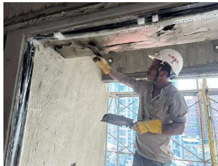
8F外牆打底施作
